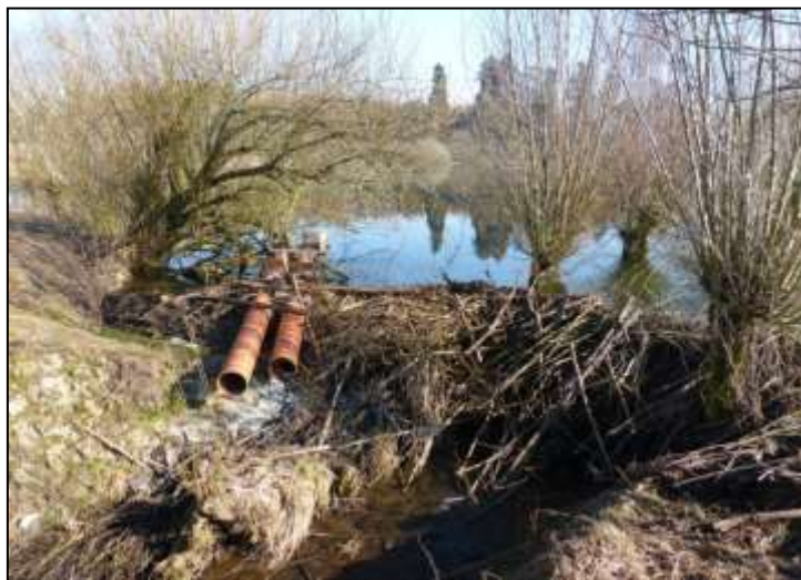
Abb. 31: Biberdamm bei zwischen Freilingen und dem Ortsteil Wölferlingen (Februar 2019): Da ein Brechen des Dammes und in einem nahe gelegenen Dorf Überflutungen befürchtet wurden, wurde der Wasserspiegel mit Genehmigung der hierfür zuständigen Oberen Naturschutzbehörde SGD Nord (Struktur- und Genehmigungsdirektion in Koblenz) durch zwei Ablaufrohre abgesenkt. Mit dieser Maßnahme sollte auch die Akzeptanz der Bevölkerung für den Biber erhöht werden
